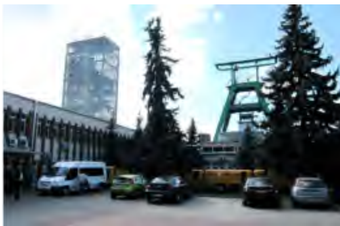
▲ Vue du chevalement de la mine de cuivre visitée à Lubin.
